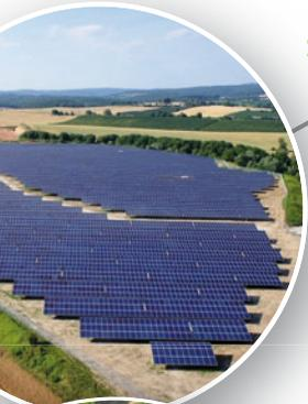
**Solarpark Lobbach-Lobenfeld:** Der Solarpark ist seit Juli 2013 am Netz. Er hat eine Leistung von 5.938 kWp und besteht aus 24.240 Modulen, die eine Solarfläche von insgesamt 95.000 m<sup>2</sup> bilden. Pro Jahr erzeugt die Anlage ca. 6.500 Megawattstunden Strom und spart jährlich rund 4.500 Tonnen CO<sub>2</sub> ein.
