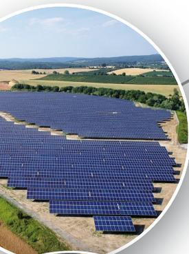
**Solarpark Lobbach-Lobenfeld:** Der Solarpark ist seit Juli 2013 am Netz. Er hat eine Leistung von 5.938 kWp und besteht aus 24.240 Modulen, die eine Solarfläche von insgesamt 95.000 m<sup>2</sup> bilden. Pro Jahr erzeugt die Anlage ca. 6.500 Megawattstunden Strom und spart jährlich rund 4.500 Tonnen CO<sub>2</sub> ein.
