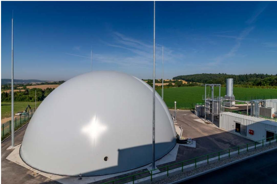
Bild 4: Gasspeicher mit einem Volumen von 5.000 m<sup>3</sup>
