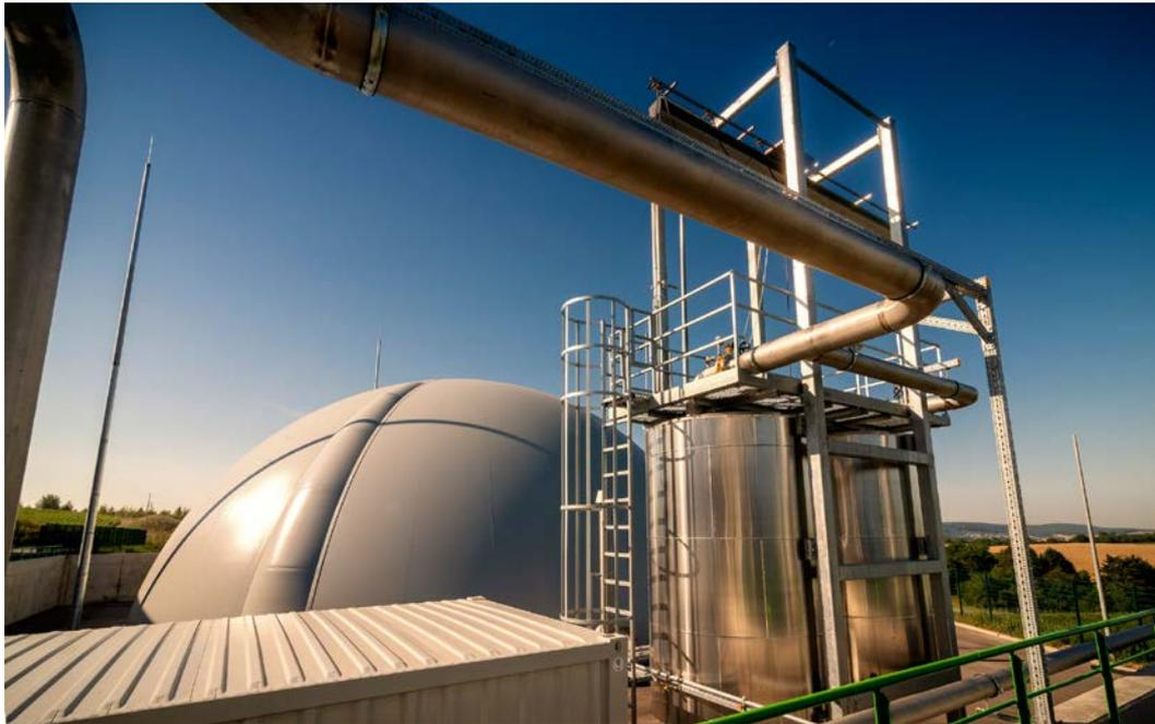
Bild 2: Für die Gasaufbereitung: Feinentschwefelung mittels Aktivkohlefilter
