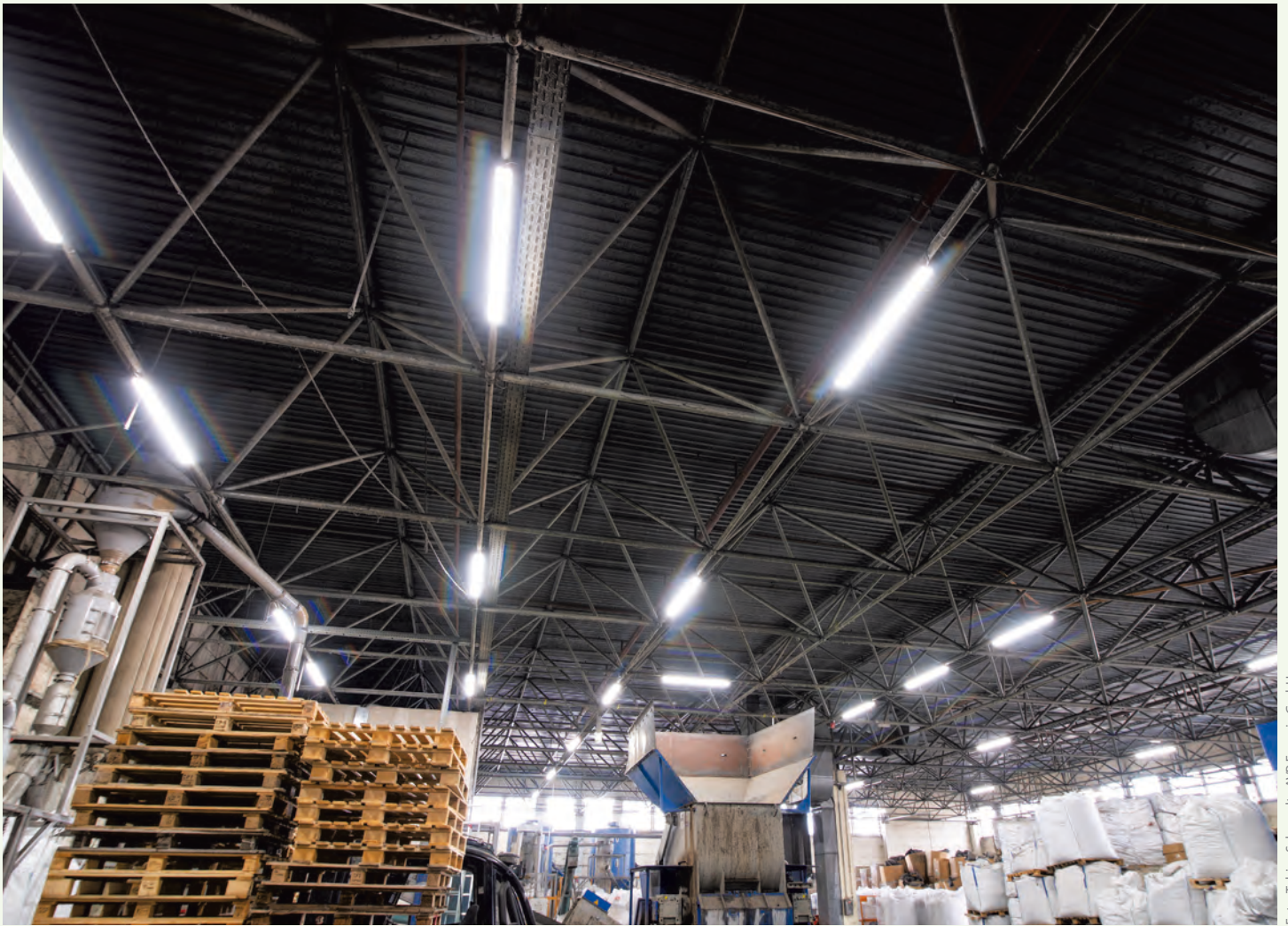
Foto: Tobias Schwerdt; AVR Energie GmbH
